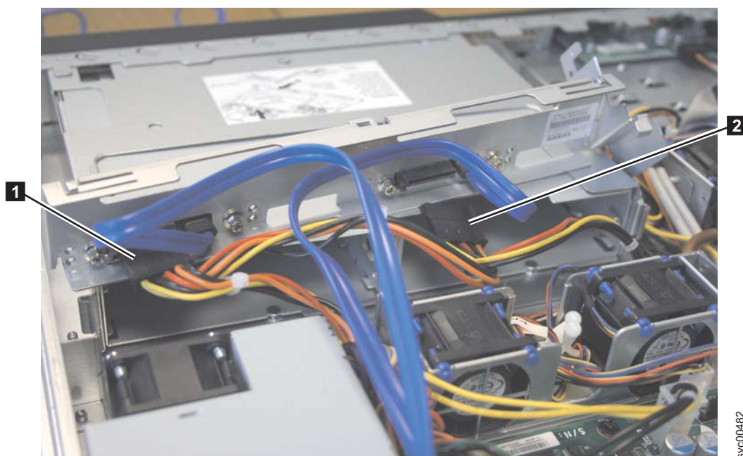
図 277. SAN ボリューム・コントローラー 2145-8A4 電源装置のコネクタ
